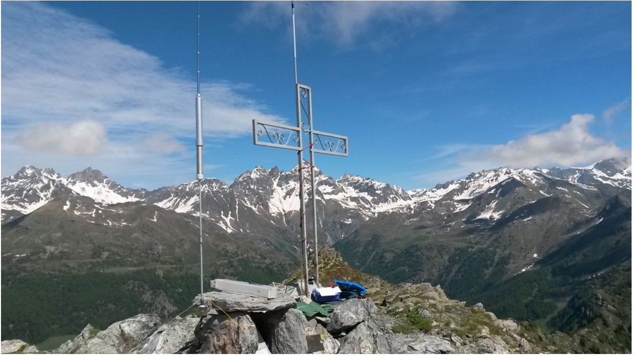
stazione ed antenne
